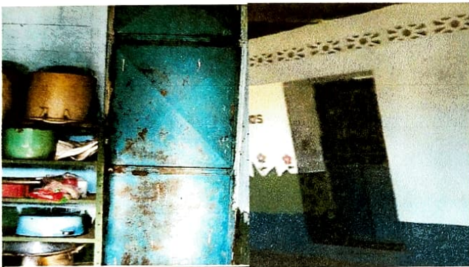
Foto 3: Mantenimiento a estructura (lijado, cepillado, aplicación de pintura) y Sustitución de Chapa.
