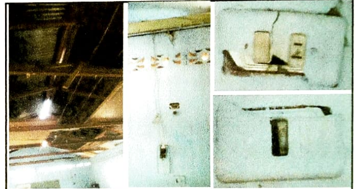
Foto 4: Reparación de Sistema Eléctrico
